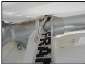
Vue de la panne sous la bâche de toit avec une sangle
